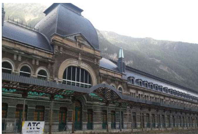
Restauración del vestíbulo de la Estación Internacional de Canfranc.
